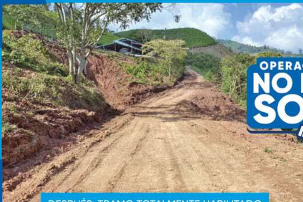
DESPUÉS: TRAMO TOTALMENTE HABILITADO
