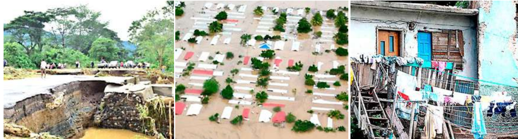
Daños | Carreteras cortadas, puentes destruidos y casas inundadas es el panorama actual de Honduras.
